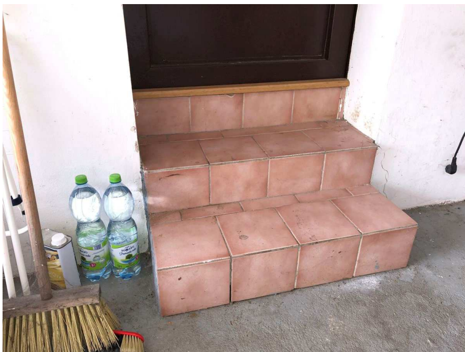
Obrázek 40: Schody do obytné části RD
