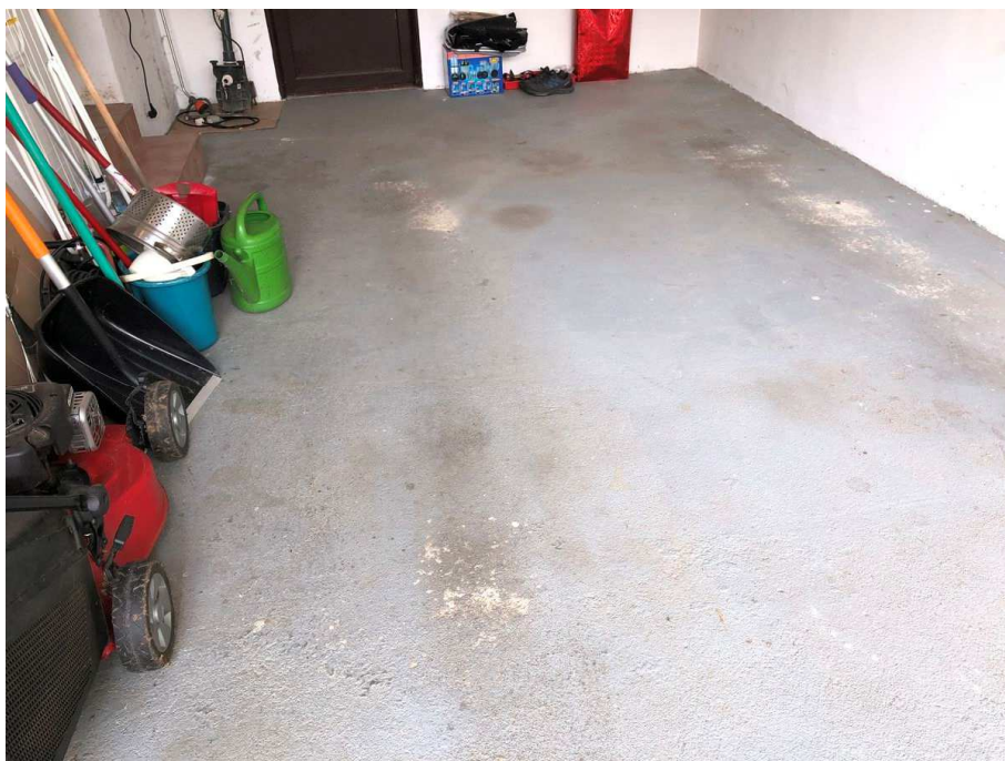
Obrázek 39: Garáž - celkový pohled na podlahu
