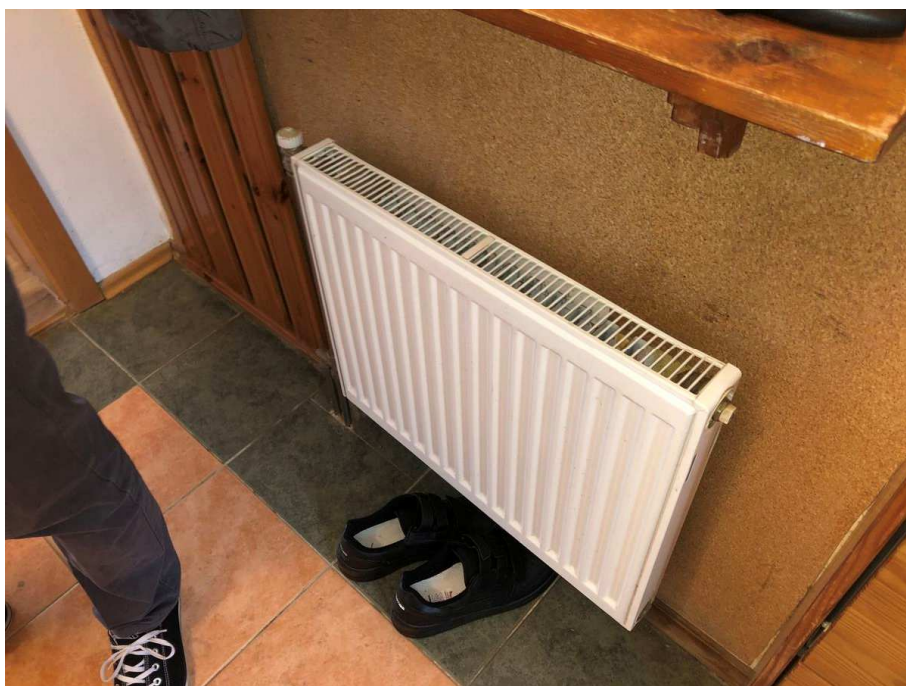
Obrázek 49: Předsíň - podlaha, topné těleso
