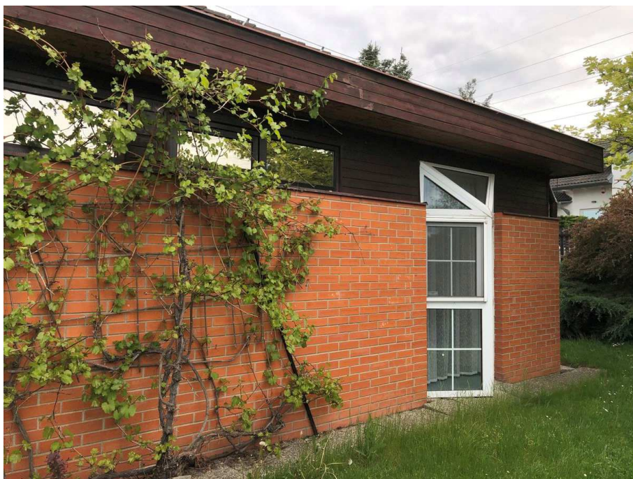
Obrázek 18: Boční stěna domu, okapový chodník, stěna porostlá popínavými keři
