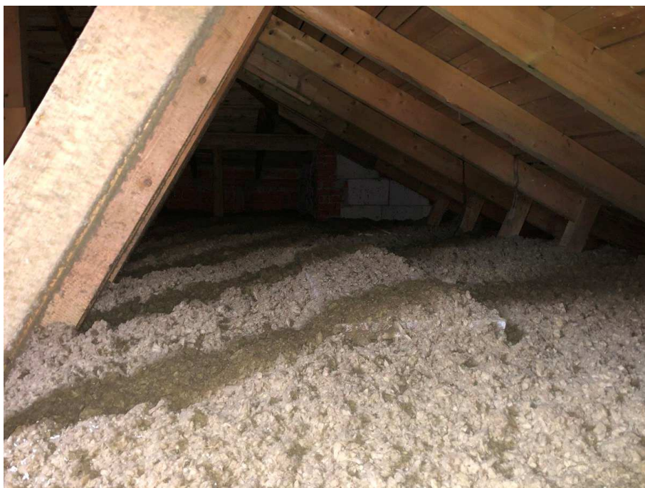
Obrázek 79: Půda - část s foukanou minerální izolací
