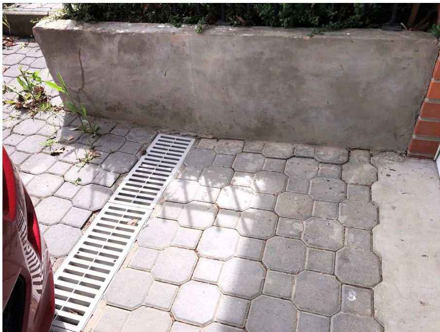
Obrázek 30: Vjezd do garáže
