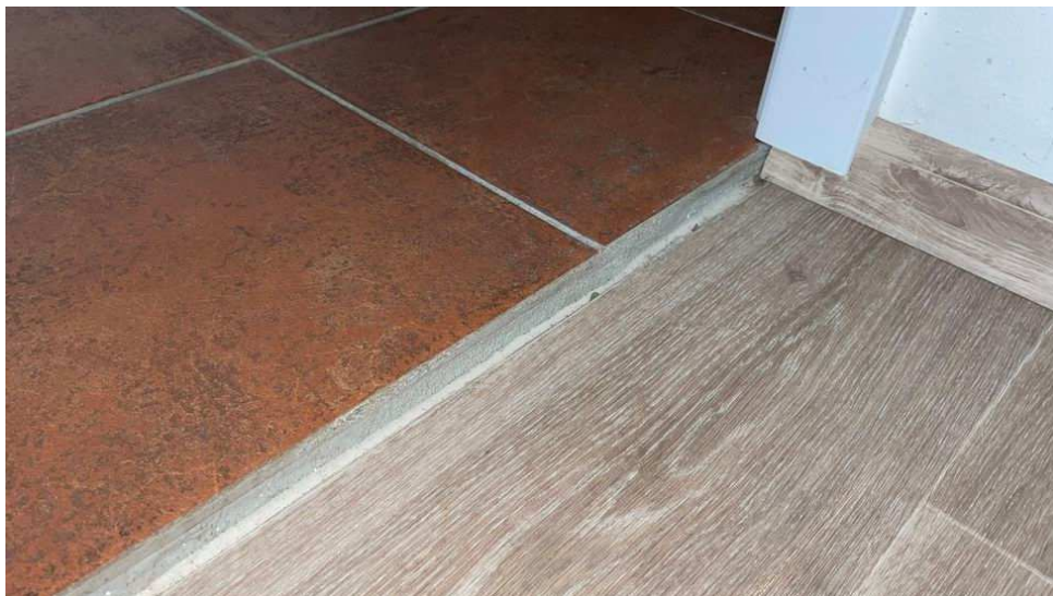
Obr. 25: Výškový rozdíl mezi původní dlažbou a novou podlahou (vpravo dole)
