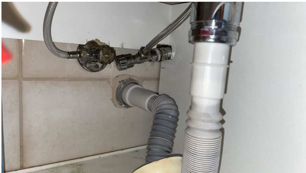
Obr. 43: Napojení umyvadla - pancéřové hadičky, flexi trubka jako sifon umyvadla
