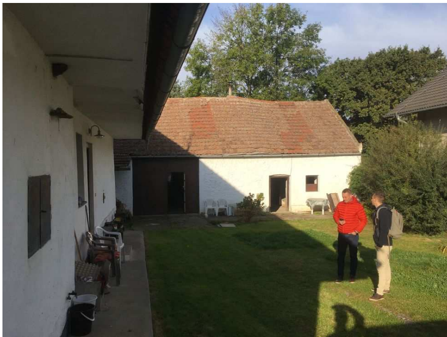
Obr. 60: Stodola, uzavírající dvůr, patrná výrazná deformace střechy
