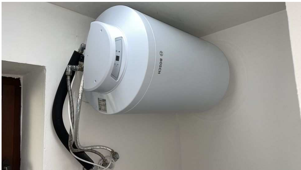
Obr. 45: Zásobníkový ohřivač TUV
