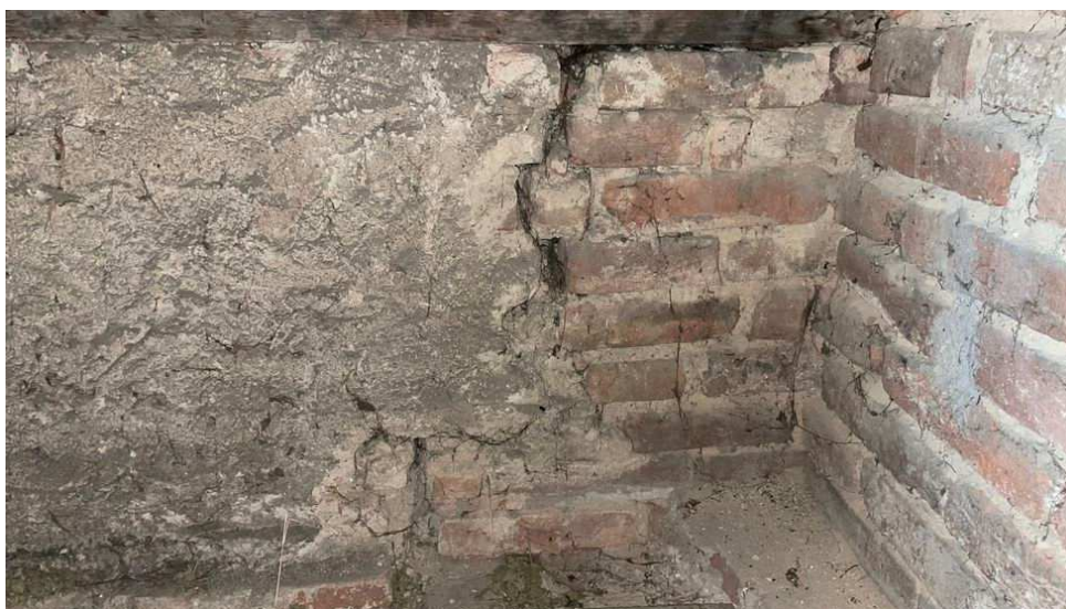
Obr. 58: Výrazné trhliny u štítové zdi, doporučujeme revizi statikem, případně zajištění
