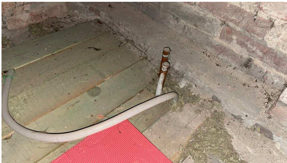
Obr. 57: Trubky topení, zavedené na půdu u štítové stěny
