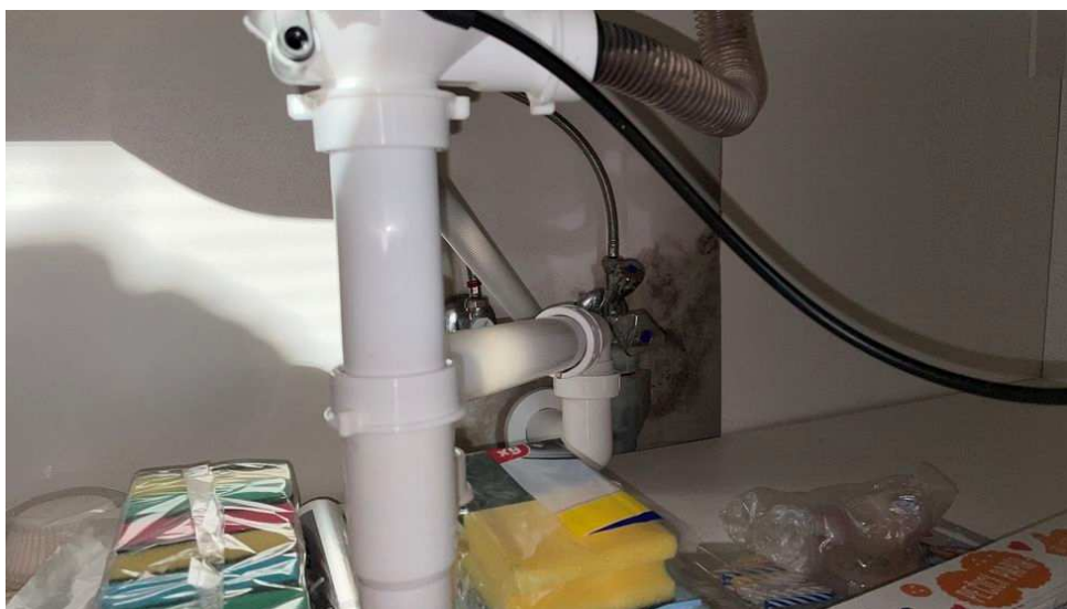
Obr. 33: Sifon kuchyňského dřezu, u napojení patrné stopy vlhkosti
