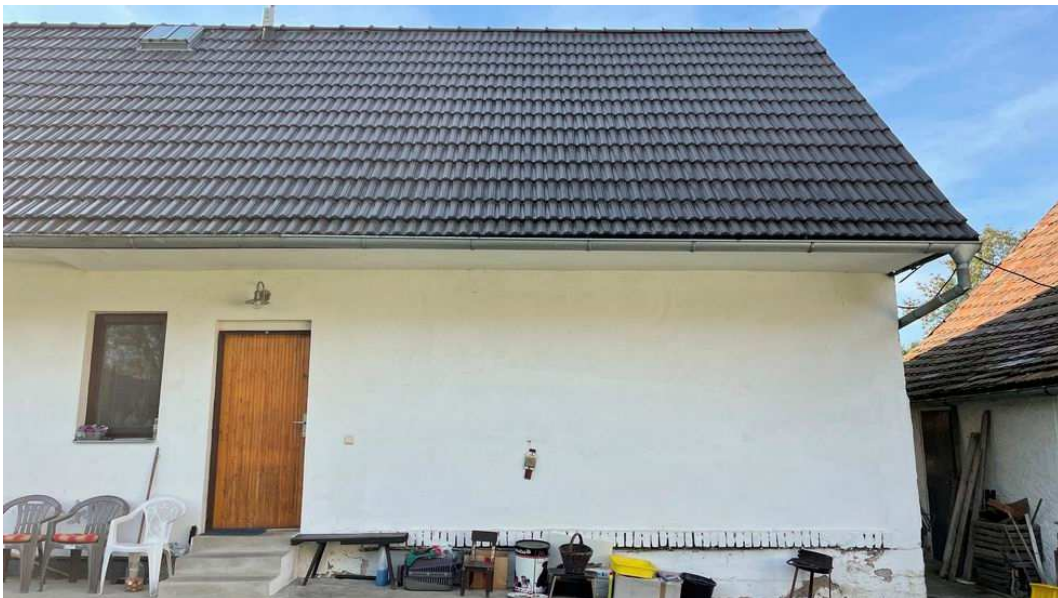
Obr. 16: Nově položená střešní krytina
