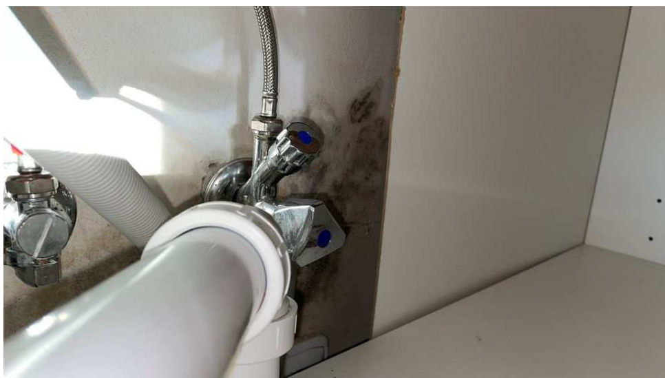
Obr. 34: Napojení dřezu, výrazné projevy vlhkosti
