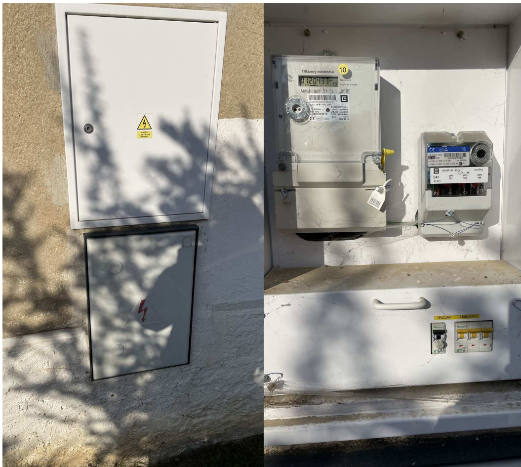
Obr. 7: Skříň s hlavním jističem a elektroměrem na uliční štítové fasádě
