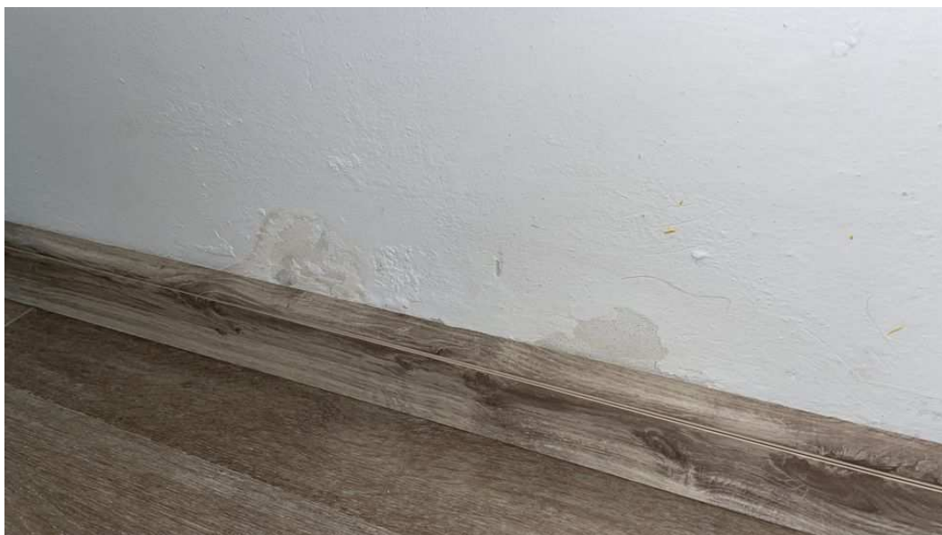
Obr. 28: Výrazné projevy vztlínající vlhkosti na obvodové stěně do zahrady
