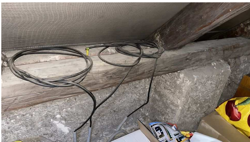
Obr. 59: Elektrické kabely, zavedené na půdu (pravděpodobně plánované zobytnění)
