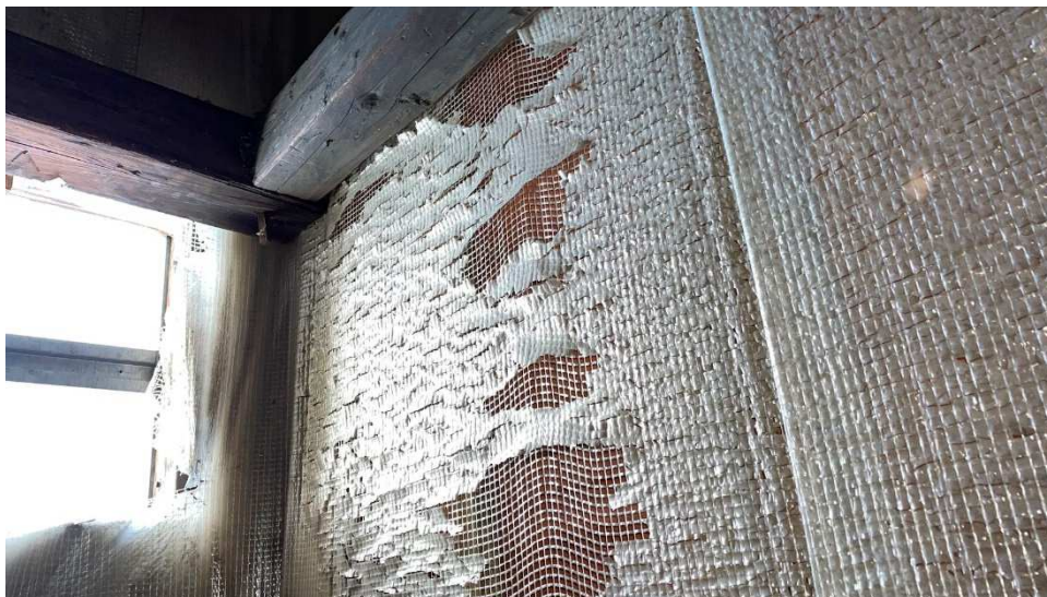
Obr. 54: Silně narušená střešní pojistná fólie (nefunkční)
