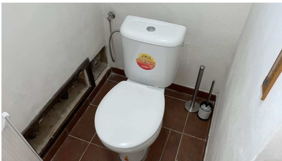
Obr. 46: WC mísa, vlevo nika s vodoměrnou sestavou a hlavním uzávěrem vody
