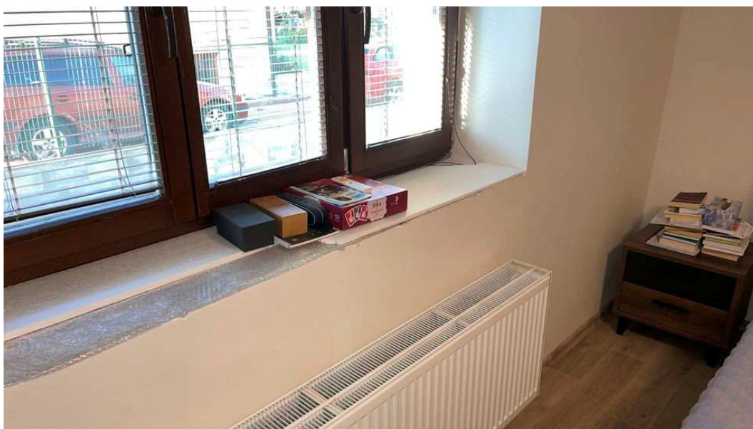
Obr. 13: Okno v ložnici, chybí vnitřní parapet (zakryto pouze tenkým polystyrenem)
