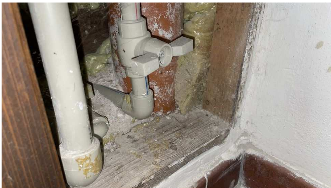
Obr. 48: Ventil za vodoměrnou sestavou, pravděpodobně k zahradní výpusti na dvoře
