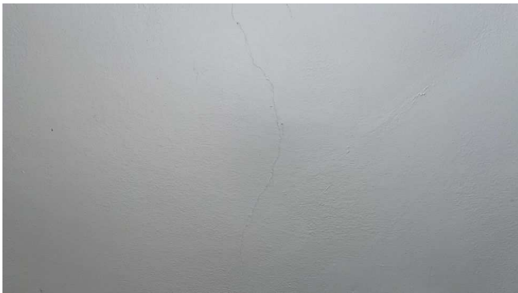
Obr. 29: Trhlina v obvodové stěně, průběžná až ke stropu
