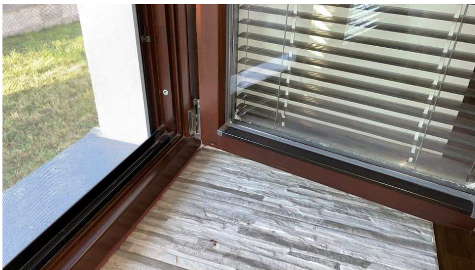
Obr. 32: OP - okno do zahrady, parapet z obkladaček
