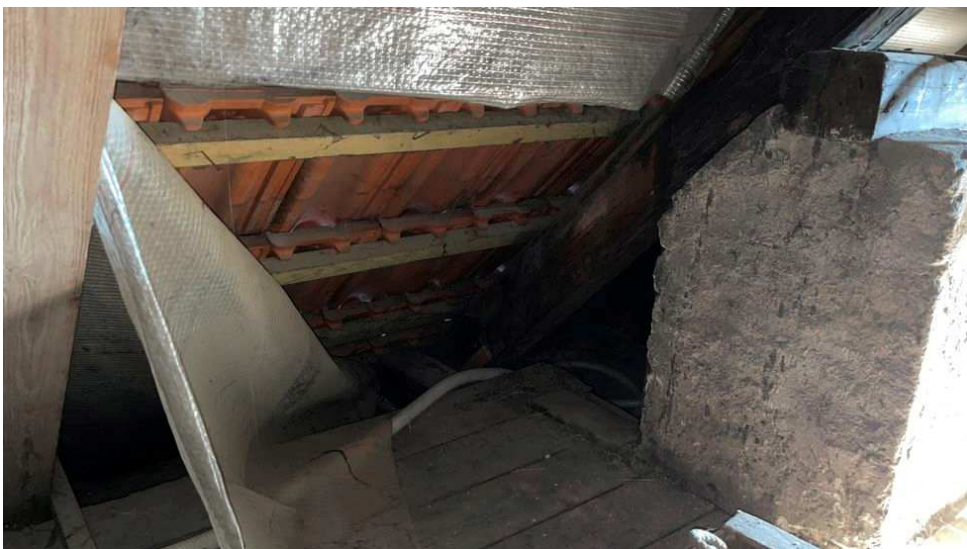
Obr. 53: Chybějící podstřešní pojistná fólie
