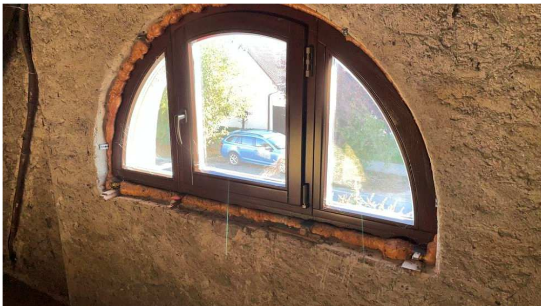
Obr. 15: Atypické okno do půdy, montážní PUR pěnu je nutné seříznout a zakrýt!
