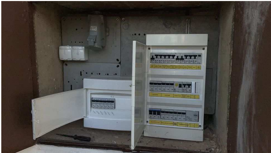
Obr. 9: Skříň s rozvaděči na dvorní fasádě
