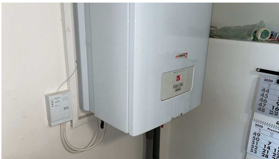
Obr. 26: Elektrokotel Protherm RAY 9K
