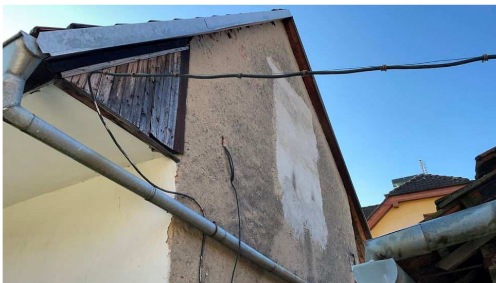
Obr. 5: Štítová stěna, odvrácená od ulice
