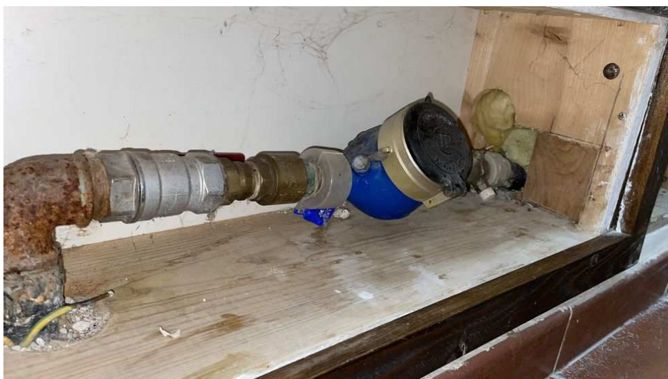
Obr. 47: Vodoměrná sestava v nice u podlahy
