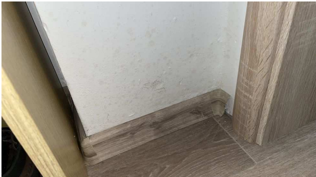
Obr. 42: Vlhkost spodní části stěny u dveří
