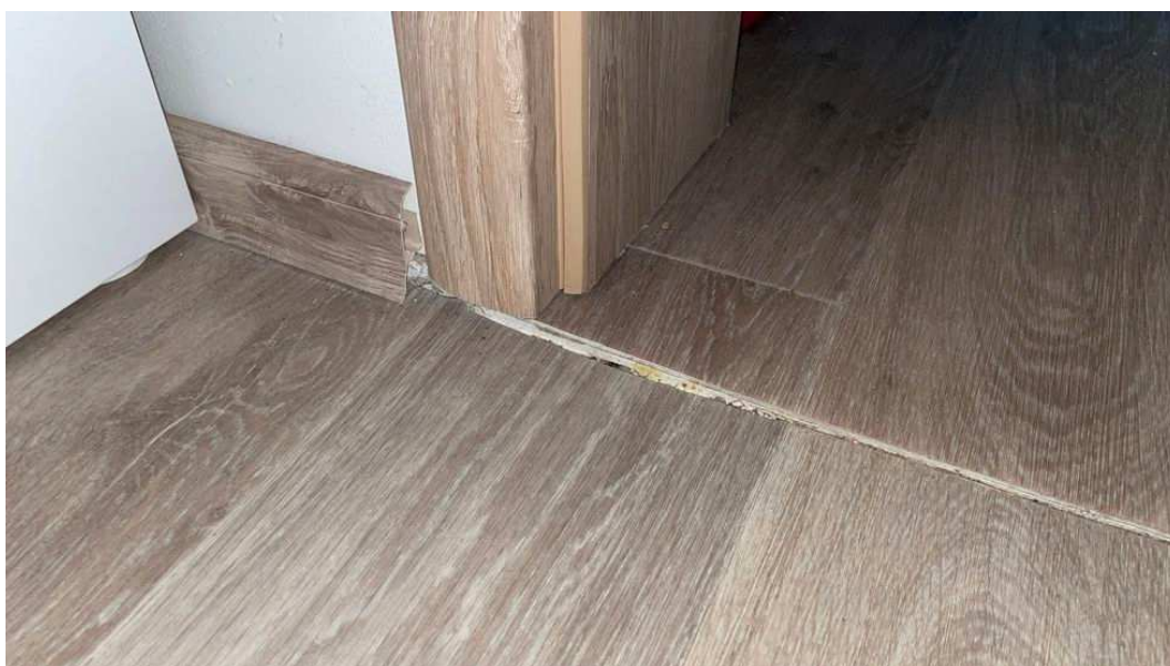
Obr. 40: Chybějící práh / přechodová lišta u dveří do ložnice
