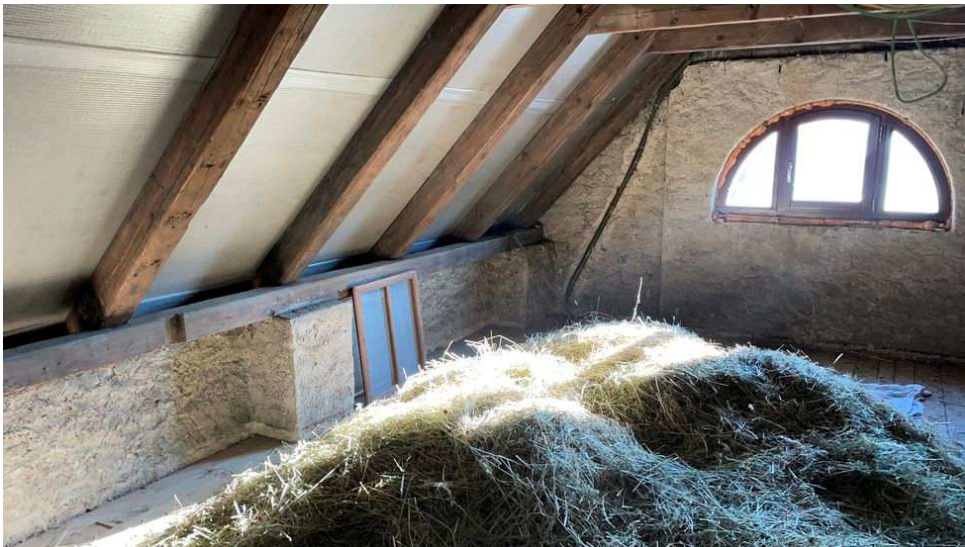
Obr. 17: Celkový pohled do půdního prostoru
