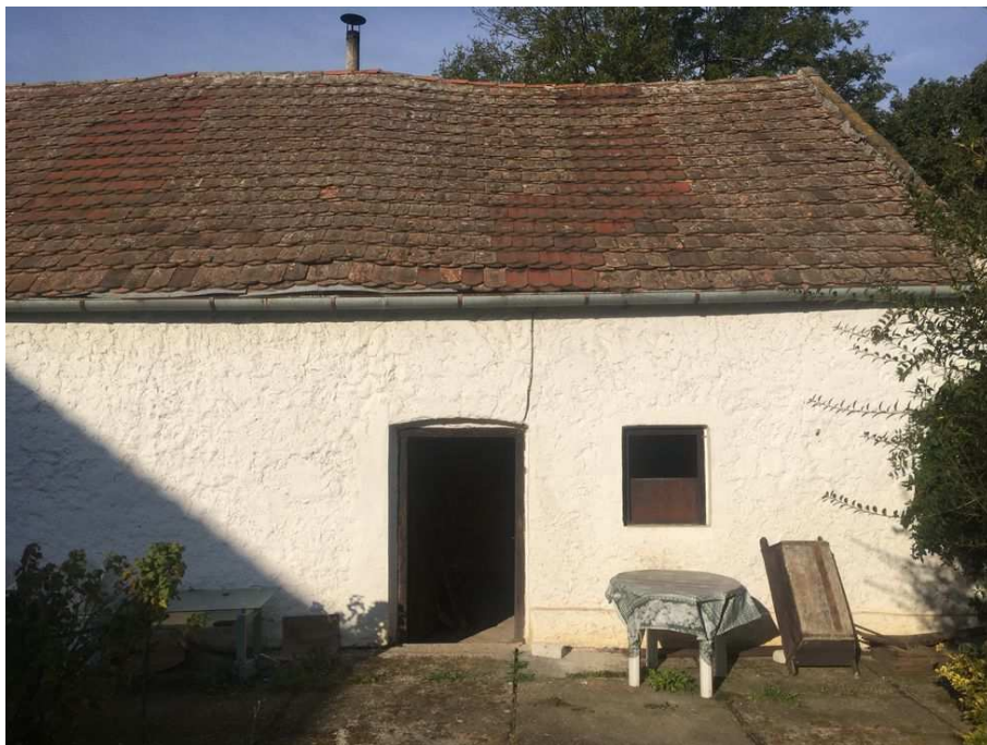
Obr. 62: Výrazná deformace střechy stodoly, v podstatě havarijní stav
