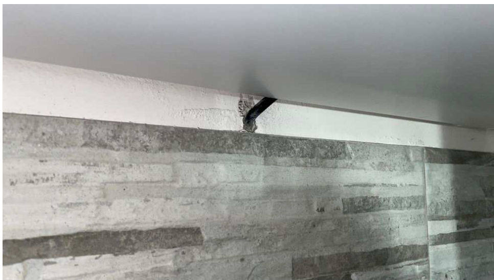
Obr. 35: Nedotažený obklad pod horními skříňkami, odkrytý kabel osvětlení
