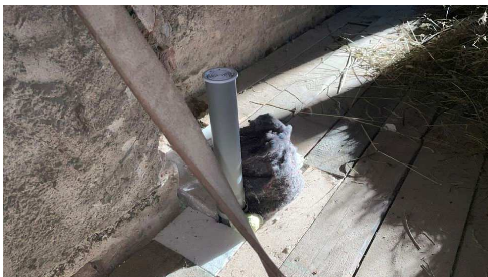
Obr. 56: Nevhodné zaústění odvětrání kanalizace z koupelny do půdy
