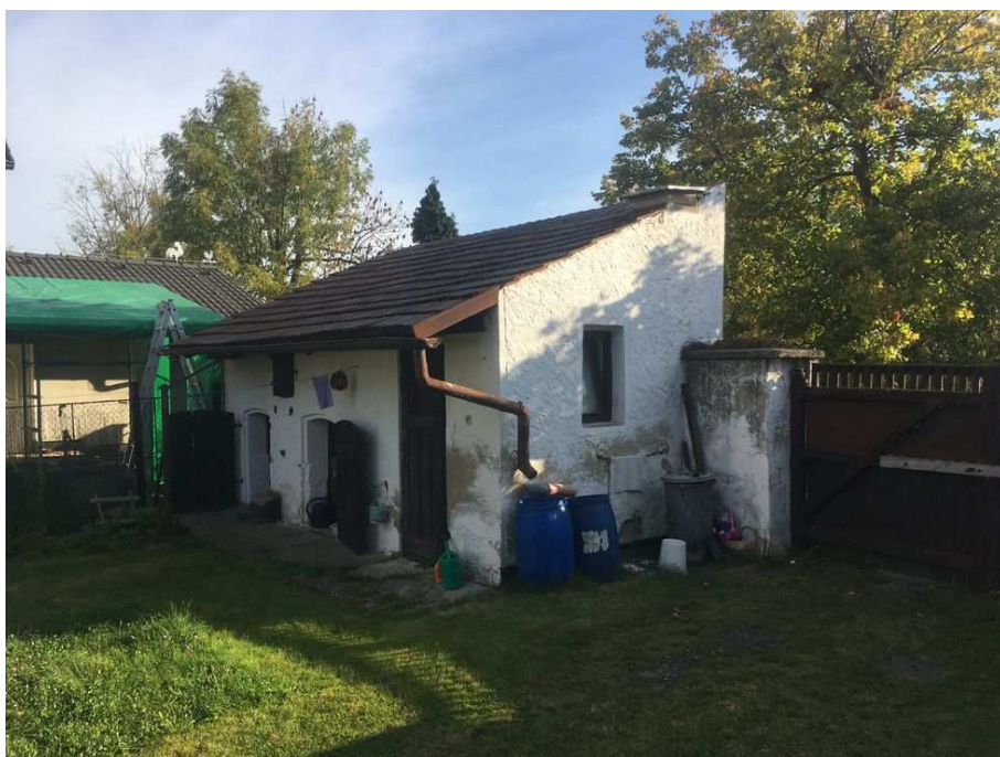
Obr. 61: Chlévy v původním stavu, slouží jako sklad
