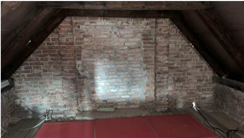
Obr. 52: Štítová stěna od ulice
