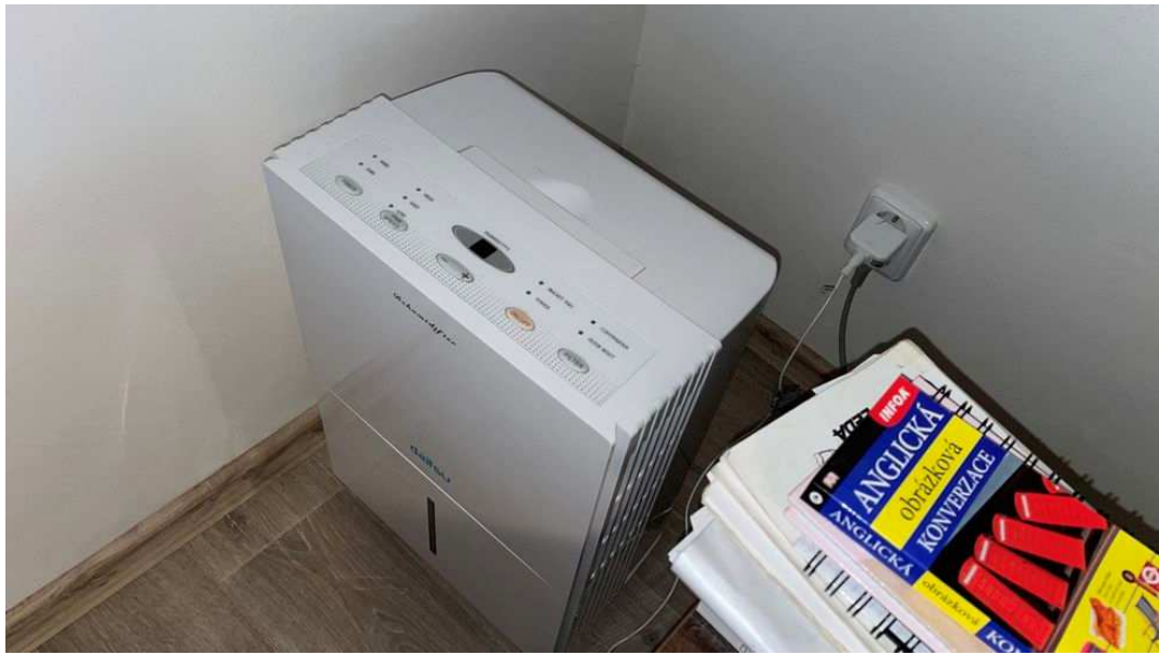
Obr. 41: Odvlhčovač v nejproblematičtějším koutě ložnice
