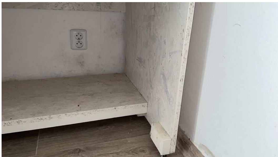
Obr. 38: Vzlínající vlhkost v rohu budovy
