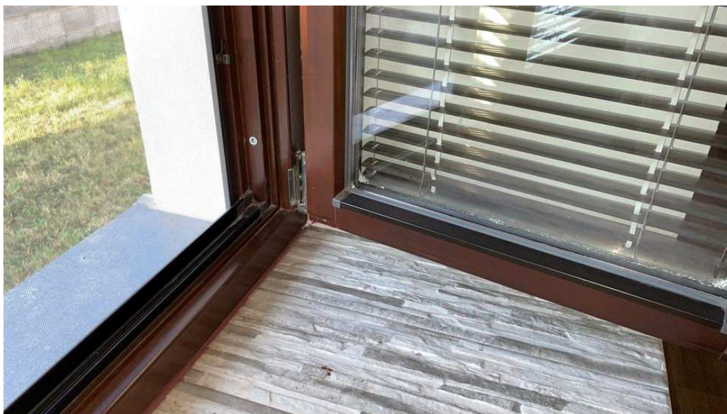
Obr. 14: Okno v OP do zahrady, parapet z keramických obkladaček
